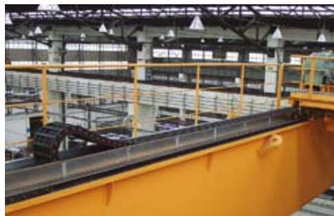
➡ Applicazione su gru di sollevamento
