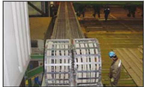
📍 Linea di saldatura costruzione navale
